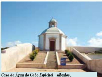
Casa da Água do Cabo Espichel | sábados, domingos e feriados
