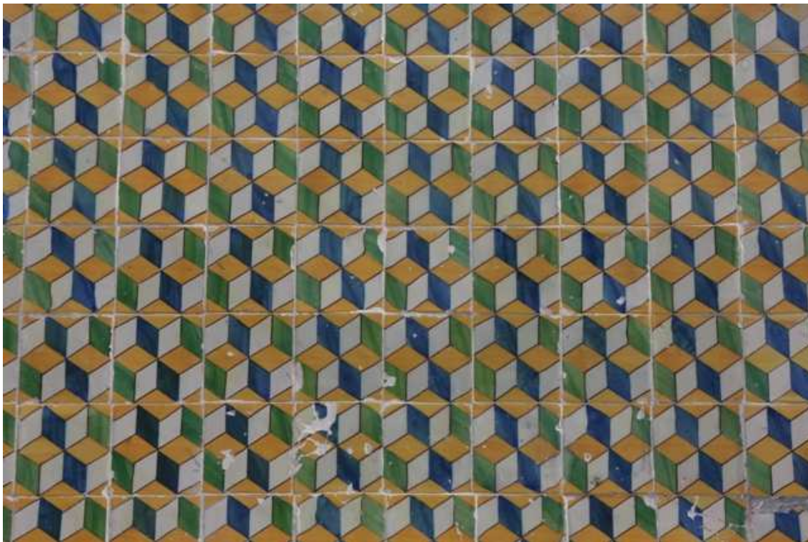
Fig. 8 – Grémio Sesimbrense. Detalhe do revestimento de azulejo. Fotografia: Rui João Rodrigues (DCI).
