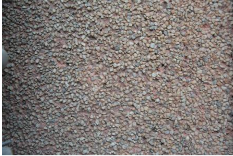
Fig. 10 – Detalhe do revestimento do terço térreo da fachada Sul. Foto: Museu Municipal.
