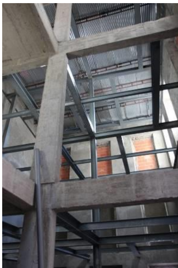
Fig. 20 – Perspectiva interior da consolidação e reforço estrutural do edifício levados a cabo em 2008. Foto: Museu Municipal.
