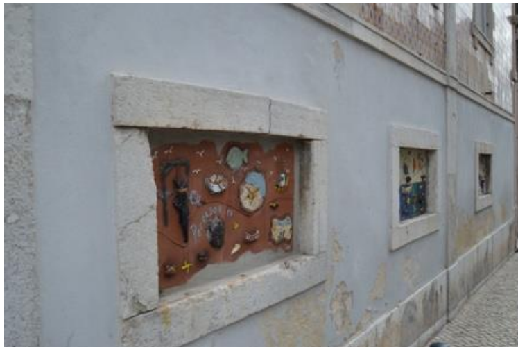
Fig. 15 – Detalhe das molduras de cantaria dos vãos - janelas do piso térreo da fachada Oeste. Foto: Museu Municipal.
