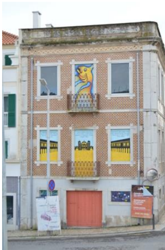
Fig. 4 – Aspecto da fachada Norte, confinante com o Jardim Municipal. Foto: Museu Municipal.
