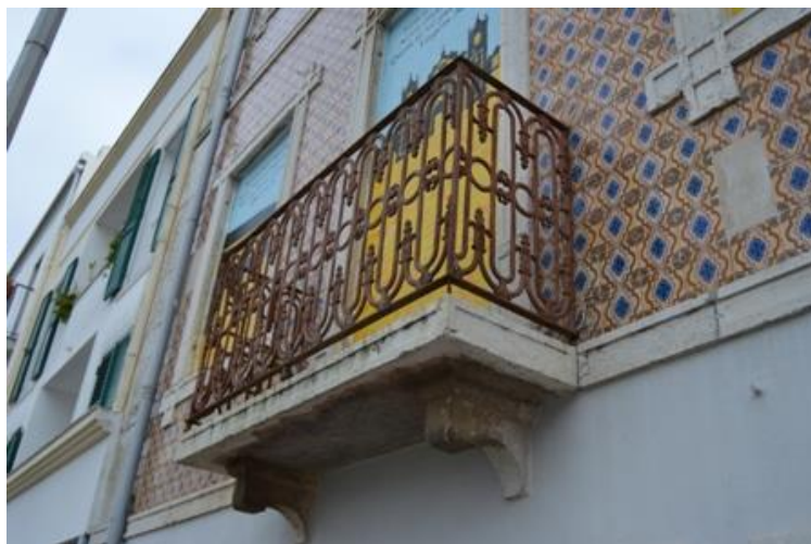
Fig. 16 – Detalhe das cantarias e gradeamentos dos vãos - janelões do 1º piso da fachada Norte. Foto: Museu Municipal.
