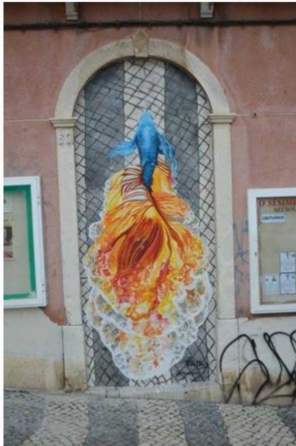
Fig. 11 – Detalhe da moldura de cantaria de um dos três vãos – portas, do piso térreo da fachada Sul. Foto: Museu Municipal.
