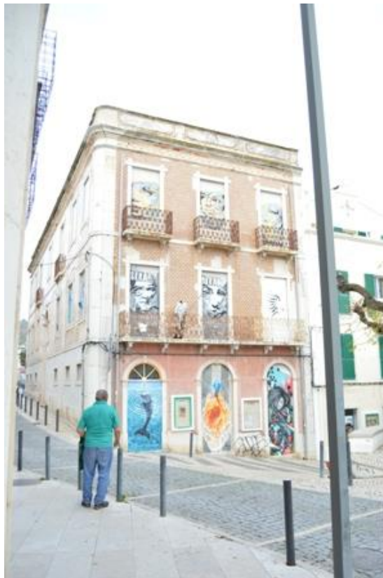
Fig. 8 – Fachada Sul do edifício, confinante com o Largo António José Pereira. Foto: Museu Municipal.
