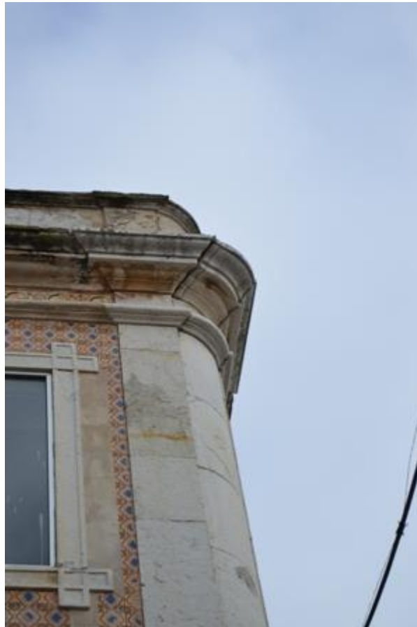
Fig. 13 – Aspecto sudoeste da platibanda do edifício. Foto: Museu Municipal.
