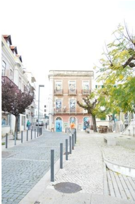
Fig. 9 – Fachada Sul do edifício, confinante com o Largo António José Pereira. Foto: Museu Municipal.
