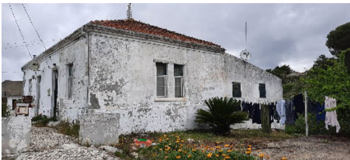
Figura 30. Edifício disperso de propriedade municipal em Fonte de Sesimbra
