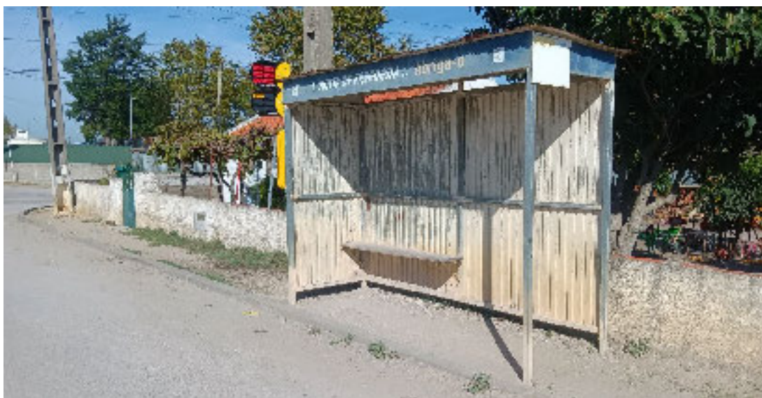
Figura 73. Paragem com abrigo – modelo em “L” com chapa metálica
