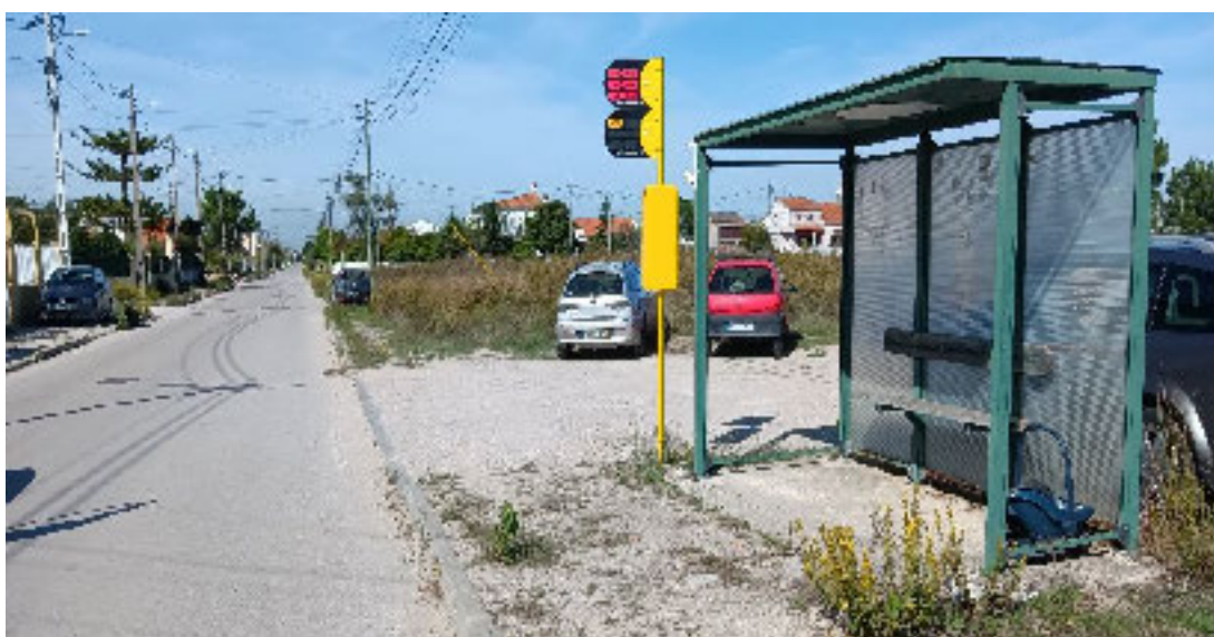
Figura 72. Paragem com abrigo – modelo sem painéis laterais e com painéis de policarbonato
