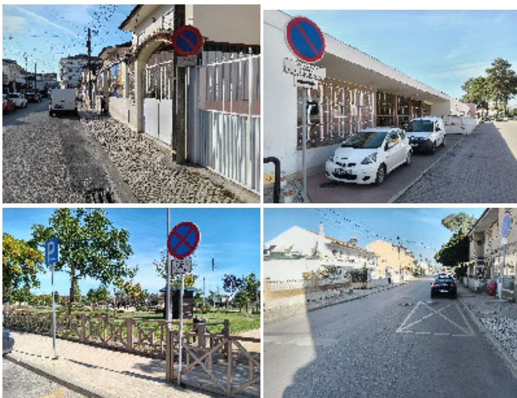
Figura 97. Exemplos de sinalização vertical para operações de carga e descarga – Rua Sousa Martins (cima, esq.), Rua Manuel Arriaga (cima, dir.), Avenida Norton de Martins (baixo, esq.), Rua Doutor Egaz Moniz (baixo, dir.)
