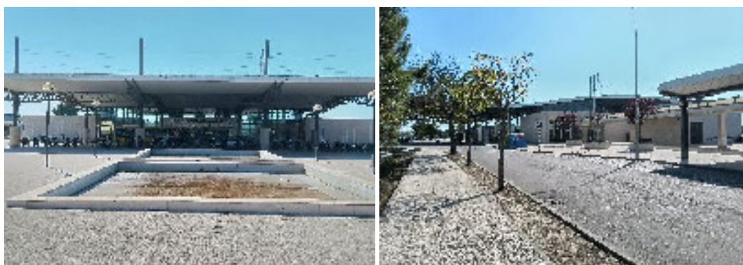
Figura 81. Estação Ferroviária de Coina
