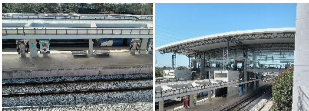
Figura 84. Características infraestruturais das plataformas de embarque da Estação Ferroviária de Coina e acesso pedonal entre ambas
