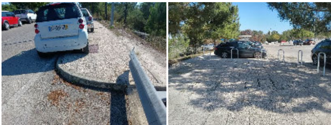
Figura 83. Constrangimentos no acesso pedonal à Estação Ferroviária da Coima
