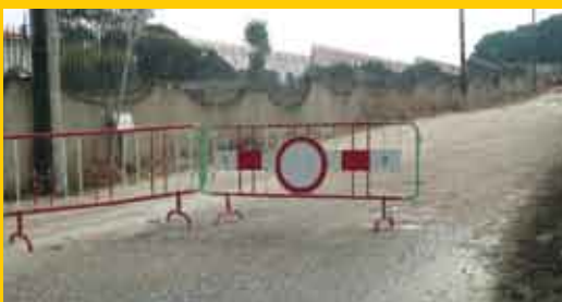
Pavimentação da Rua Abade Faria na Charneca da Cotovia
