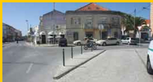
Concluída a obra no cruzamento da praça de táxis em Santana
