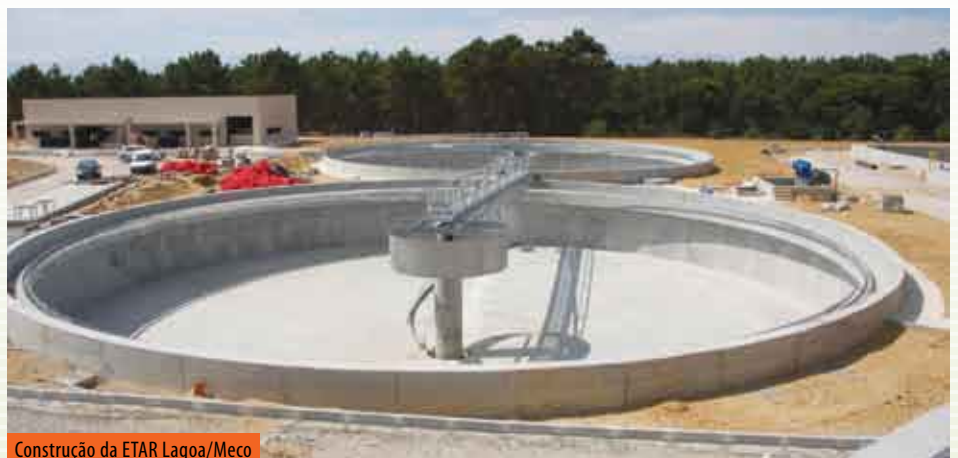
Construção da ETAR Lagoa/Meco
