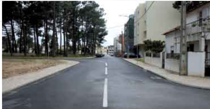
A pavimentação das ruas representa um investimento que ultrapassa o milhão e meio de euros.
