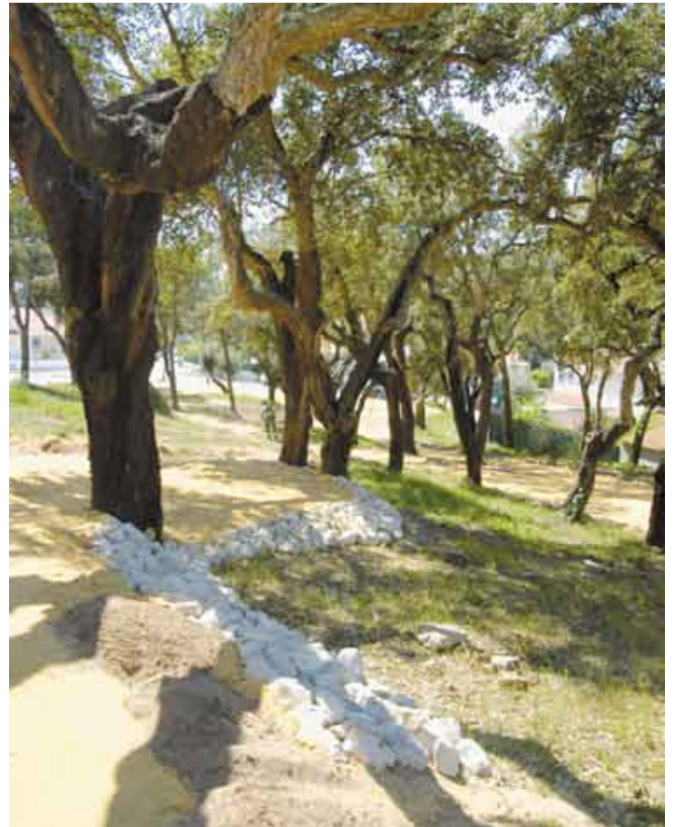
Neste momento a autarquia está a construir os caminhos pedonais
