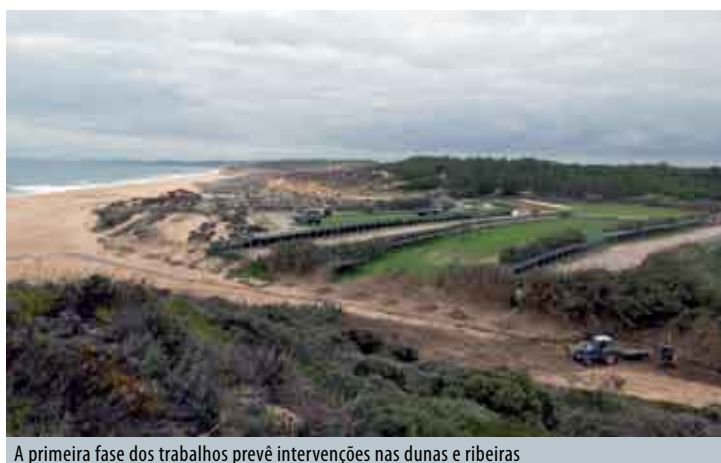
A primeira fase dos trabalhos prevê intervenções nas dunas e ribeiras
