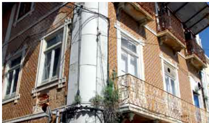
A autarquia optou por recuperar o sótão do edifício, aumentando assim as áreas úteis
