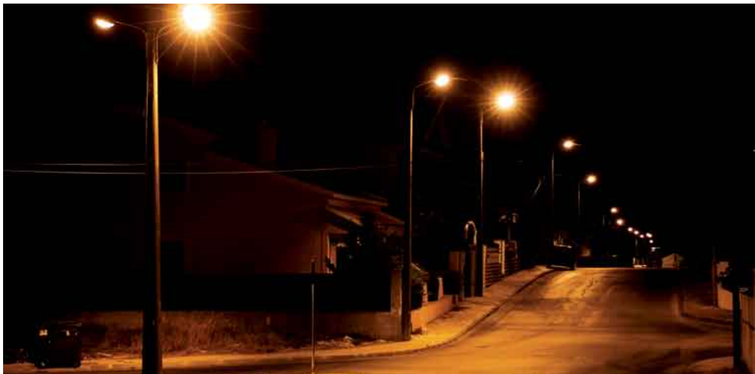
As novas lâmpadas que foram instaladas em várias ruas do Conde 1 vão permitir melhorar a segurança de pessoas e bens
