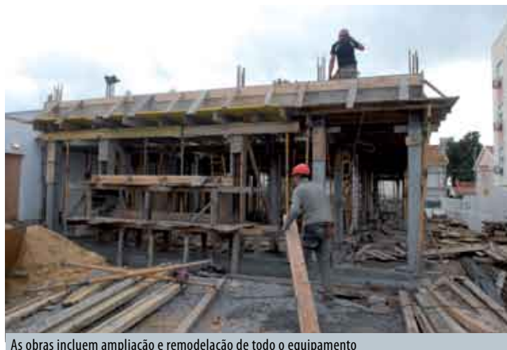
As obras incluem ampliação e remodelação de todo o equipamento
