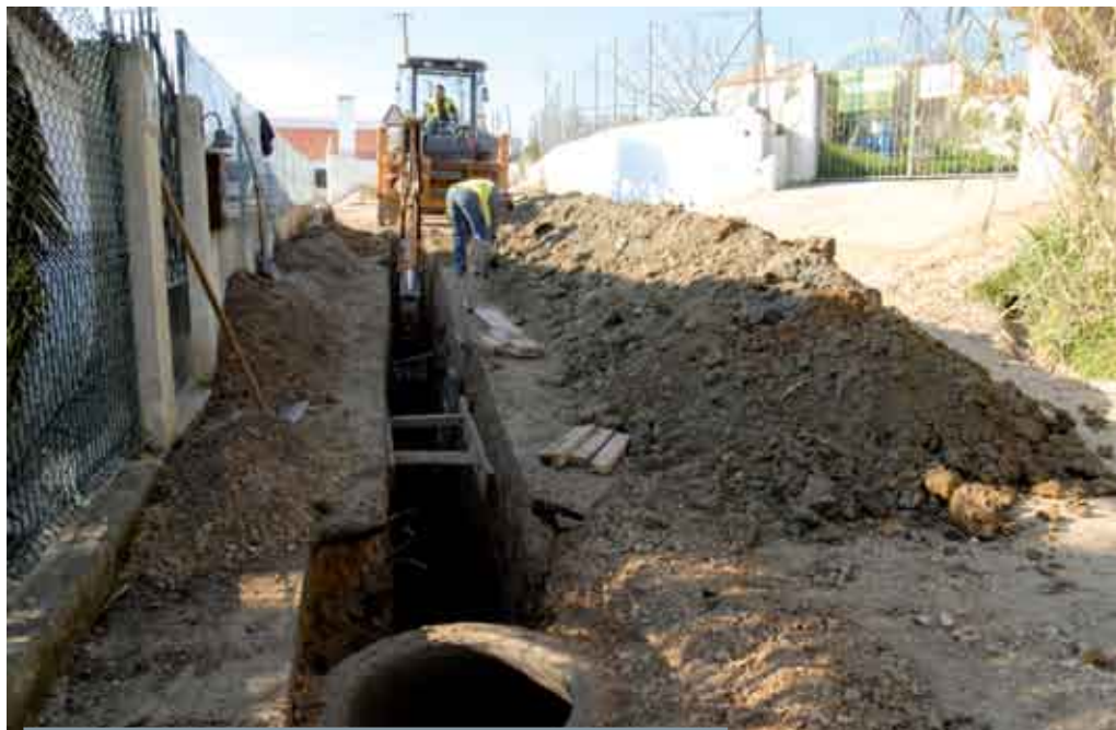
As obras contemplam a instalação de 8 quilómetros de coletores e ramais
