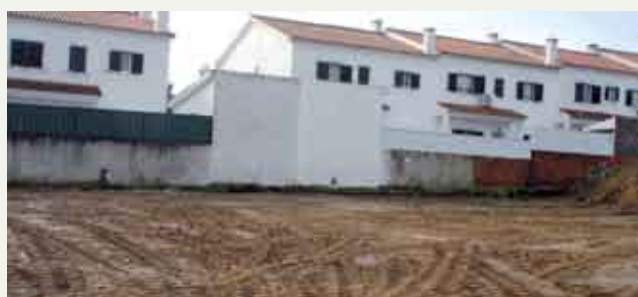
7 Prédio urbano designado por lote n.º 41 A, sito em Charneca da Cotovia, freguesia do Castelo; terreno para construção de moradia em banda (2 pisos e cave); área total de 161,02 m 2 ; área de superfície total de pavimentos (STP) de 131 m 2 . Base de licitação: € 42.000.
