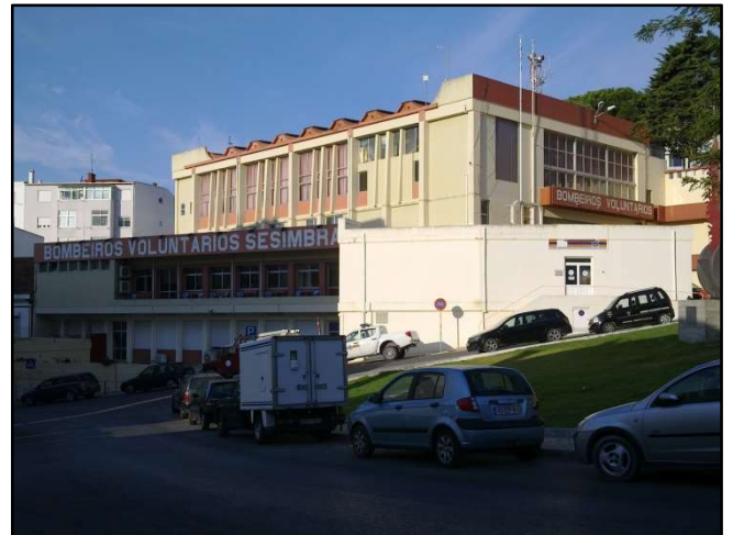
Imagem 19 – Edifício dos Bombeiros Voluntários de Sesimbra, Largo dos Bombeiros Voluntários Fonte: Própria
