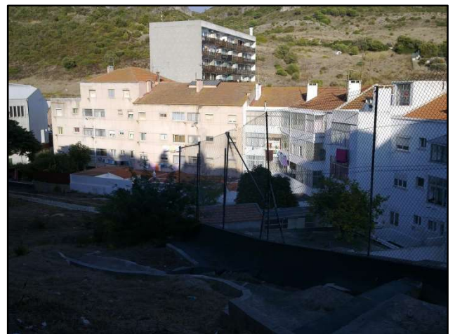
Imagem 18 – “Mata da Vila Amália”, alçados tardoz da frente de edifícios na Avenida da Liberdade, junto ao Gimnodesportivo Fonte: Própria
