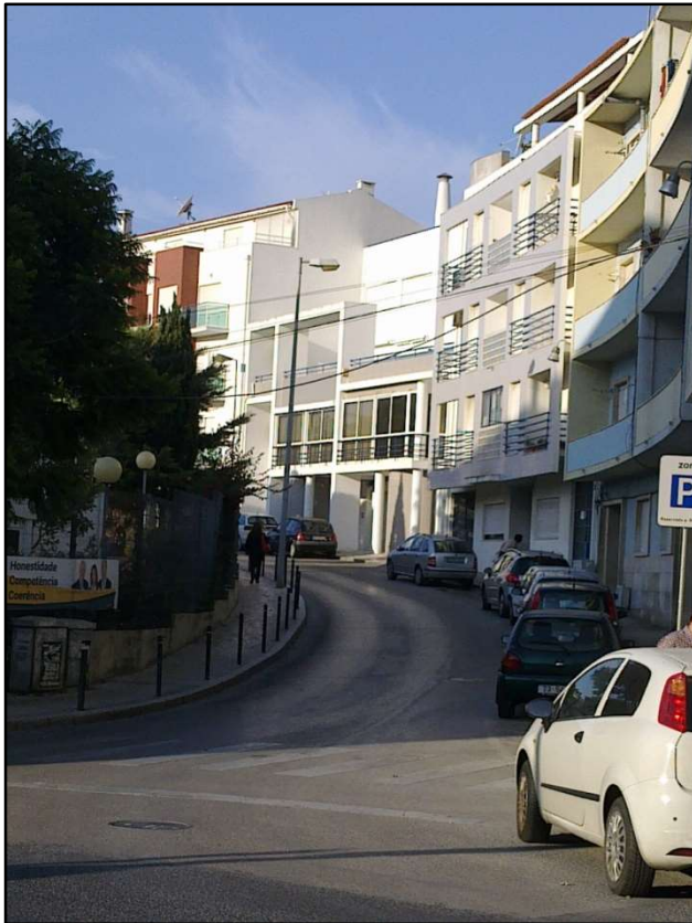
Imagem 2- Frente de edifícios situados na nova delimitação da zona envolvente - zona 3, Rua João da Luz Fonte: Própria
