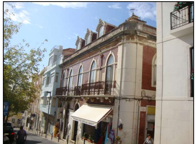
Imagem 4 - Rua Cândido dos Reis, 22 a 28 - Fachada principal de um edifício de valor arquitetónico relevante
