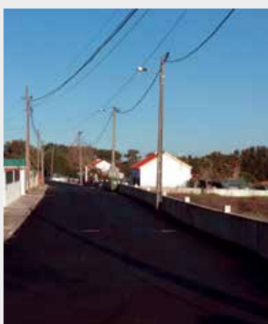
Rua Francisco Zacarias Marquês Fonte de Sesimbra Freguesia do Castelo Estado: Concluída
