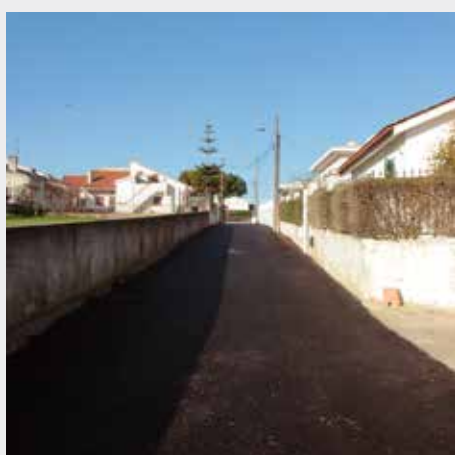
Rua Manuel Tomás Rodrigues Cotovia • Freguesia do Castelo Estado: Concluída
