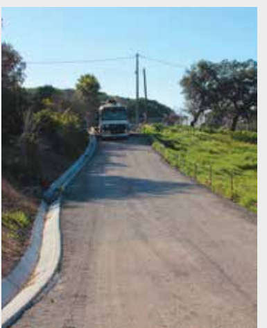
Rua Mariano Pina Venda Nova • Freguesia do Castelo Estado: Concluída
