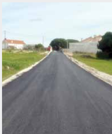
Rua dos Pinheiros Alfarim • Freguesia do Castelo Estado: Concluída
