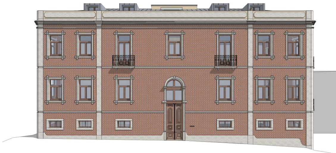
Fig 1 – Edifício onde se preconiza instalar o futuro CCM, fachada exterior
